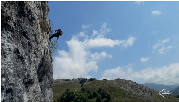
Prospecciones verticales en las paredes de Ajanedo.
